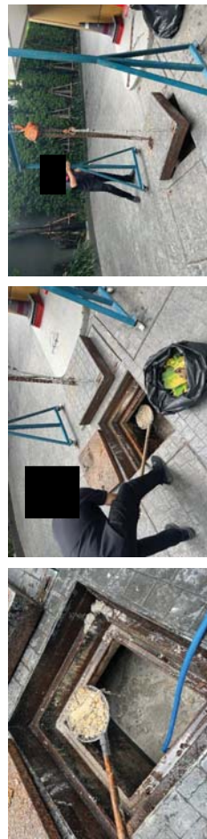
การตัดไขเมนออกจากระบบระบายน้ำ
